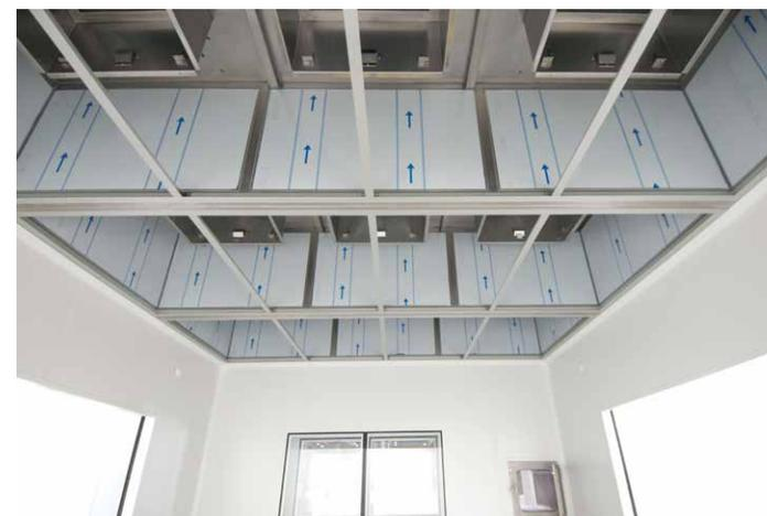
**Foto derecha:** Instalación en progreso de un flujo laminar a medida para una zona de muestreo.
