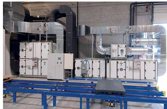
**Imagen superior:** Instalación completa de pretratamiento y tratamiento de aire de un flujo laminar de un caudal de 26.600 m<sup>3</sup>/h.
