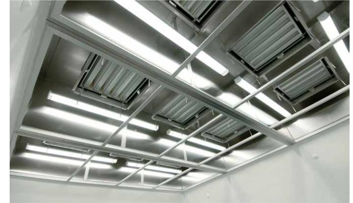
Detalle de la parte interior de un módulo de flujo laminar: Filtros absolutos y luminarias antes de colocar la tela difusora
