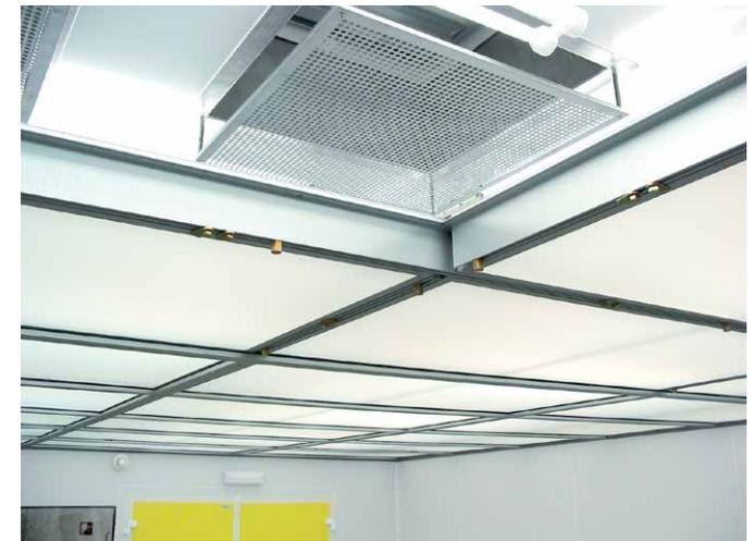
Flujo laminar instalado con una tela difusora desmontada.
