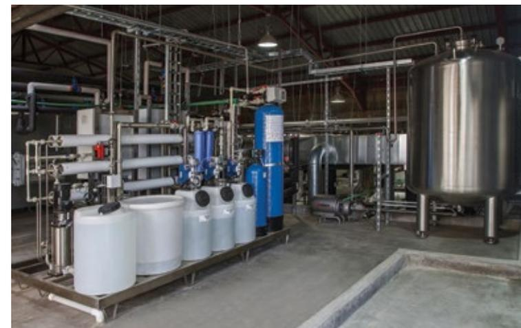
Prétraitement d'eau et génération d'eau purifiée (PW), incluant *loop* de distribution et cuve de stockage
